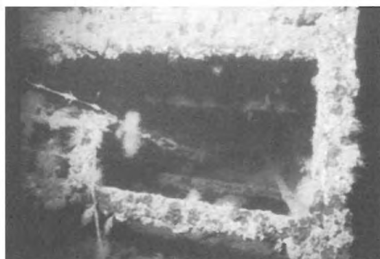
図6 魚礁1型2段目柵部破損状況
