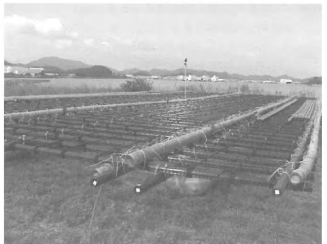
図4 総FRP製大型イカダ
