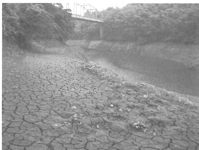
図27 左写真の遠景 (手前右側がコロニー) 旧道路跡で左奥の樹木より先の底質は砂礫
