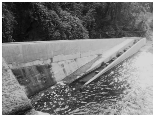
図1 第三砂防堰堤に設置された魚道
